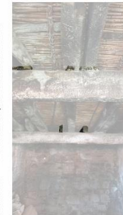
Χρήση πέτρων για την στήριξη της οροφής.
