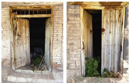
Απλές ορθογωνικές σανιδωτές θύρες και κάποιες από αυτές έχουν οριζόντιο φεγγίτη στο πάνω μέρος.
