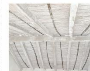
Τοποθέτηση επιπλέον καλαμιού έτσι ώστε να στηρίζονται τα υπόλοιπα στην άλλη κατεύθυνση.
